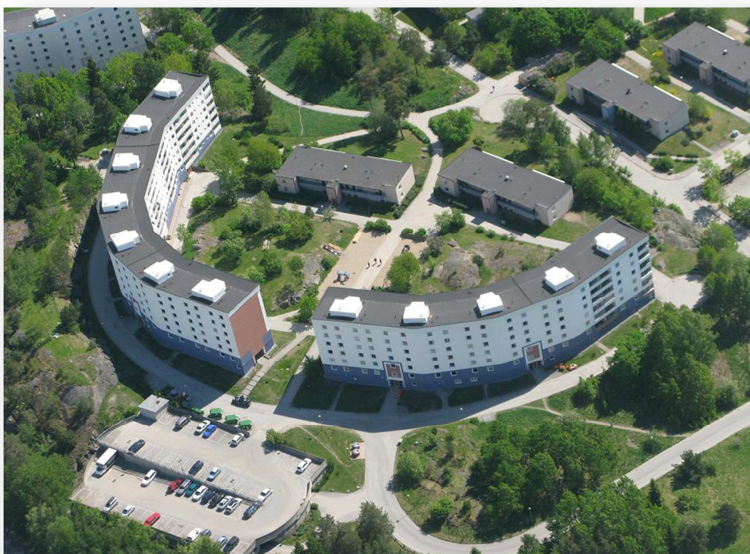
Flygfoto Branta Backen 7-15 och 17-29, Storvreten
