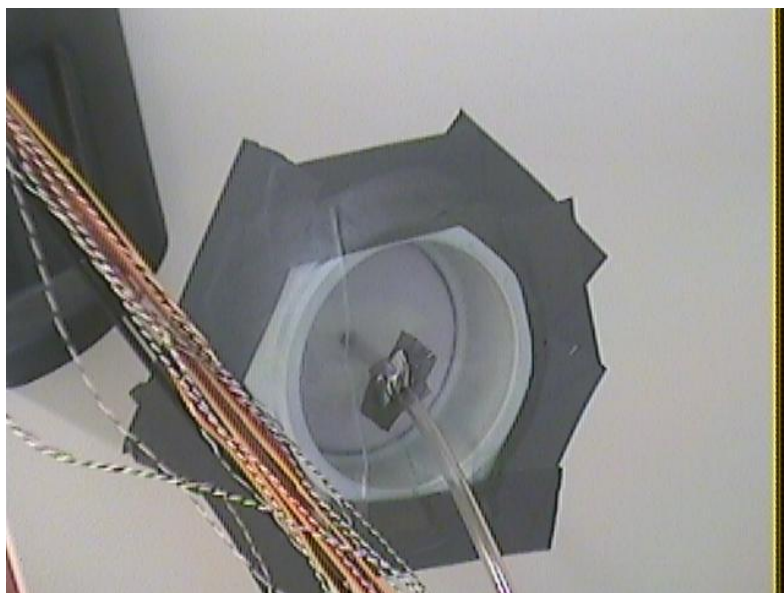
Figur 4.5, tätning av klimatskåpets ena ingång. Silikonslangen tillsammans med en tryckmätare användes för att mäta upp tryckskillnaden i klimatskåpet. Hålet i plastfolien gjordes mindre än silikonslangen för att minimera luftläckage runt slangen.
